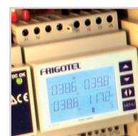
Sistema Frigotel® per la misurazione dei consumi elettrici. Frigotel® System for the electrical consumption control.
