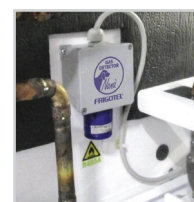
Rilevamento gas Gas detector
